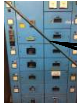
Quadro elettrico di comando
