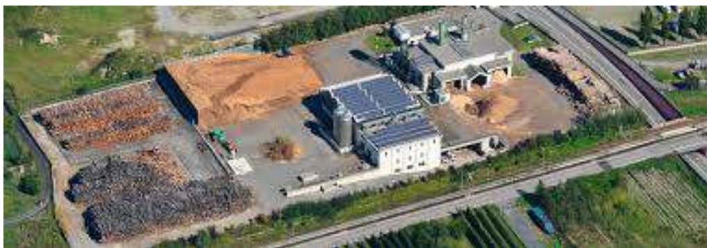
La centrale di Tirano (Fonte http://tcvvv.it/le-centrali/tirano )
