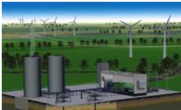
Sistema di accumulo CAES adiabatico (Progetto europeo ADELE)
