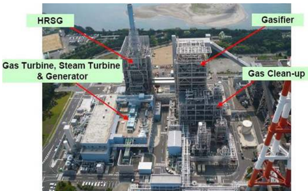
Vista dell' impianto IGCC Nakoso (Giappone) (Fonte: Mitsubishi Heavy Industries, Ltd)
