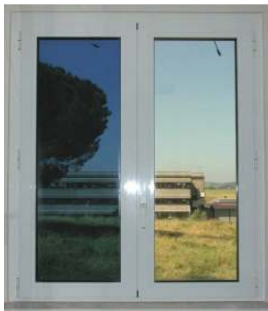
Finestra con vetri elettrocromici (Fonte: ENEA)
